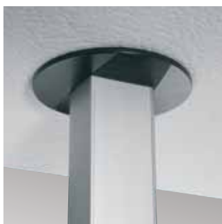
For å få en pen overgang til taket benyttes en rosett som i tillegg skjuler hulltakningen.
